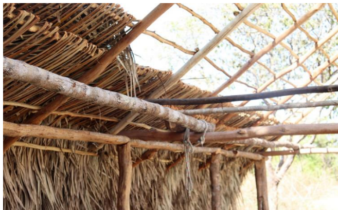
Figura 1: Parte do telhado sendo coberto
