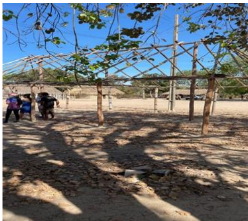
Foto 01 : Construção de moradia
