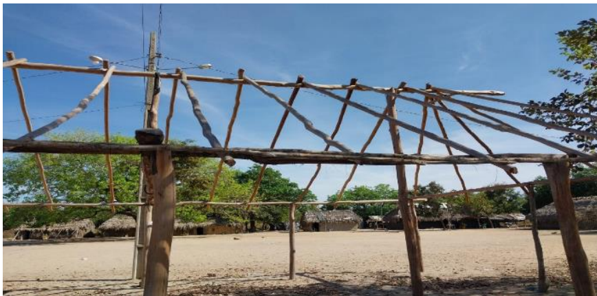
Figura 02: Casa no início da construção.
