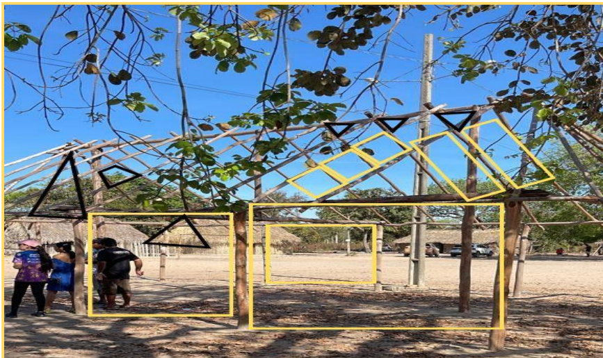
Imagem 13: Início da obra da construção de uma casa
