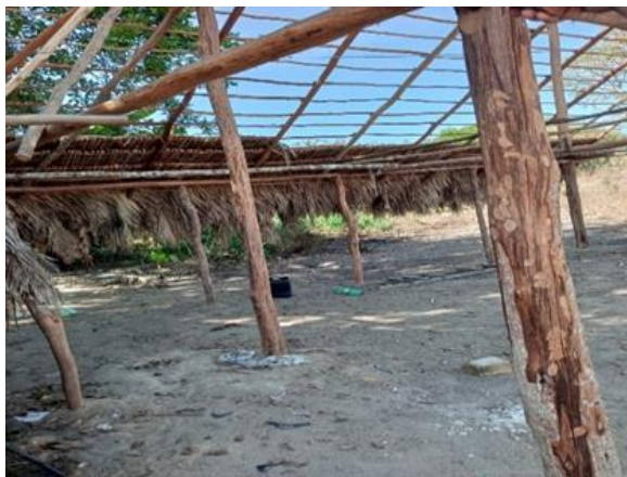
Foto 02 : Construção de moradia
