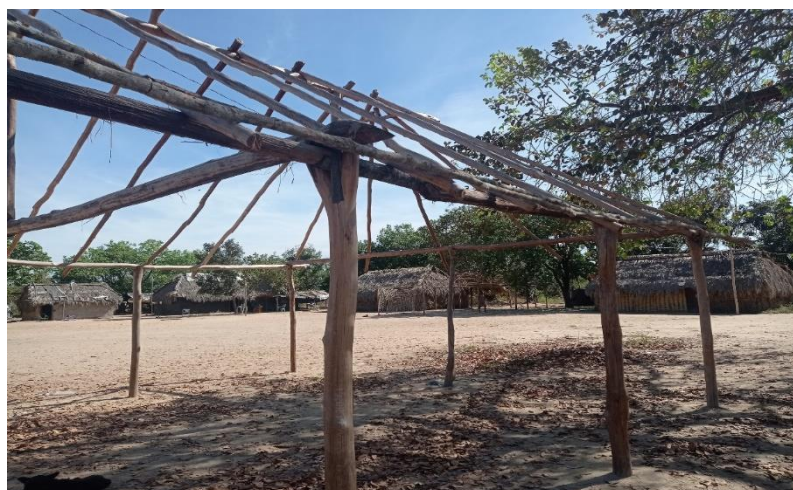
Figura 3: Construção de uma casa no centro terreno
