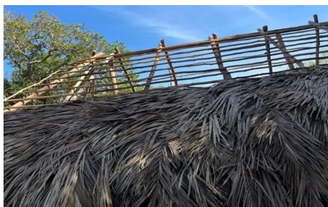
Imagem 03: Partes de outro telhado de outro tipo de moradia
